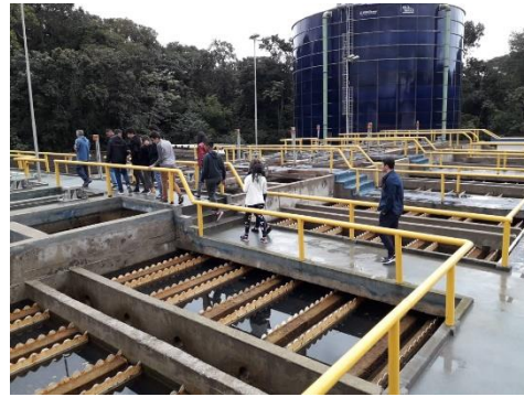
Visita Estação Tratamento Efluentes Riviera S. Lourenço
