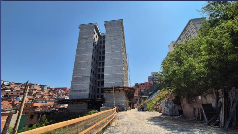
Vista lateral do bloco L
