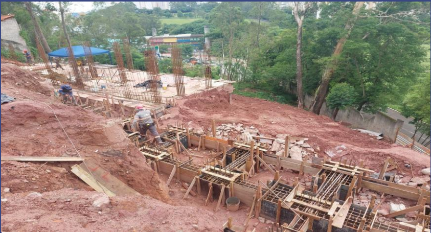
Execução da fundação Condomínio E2
