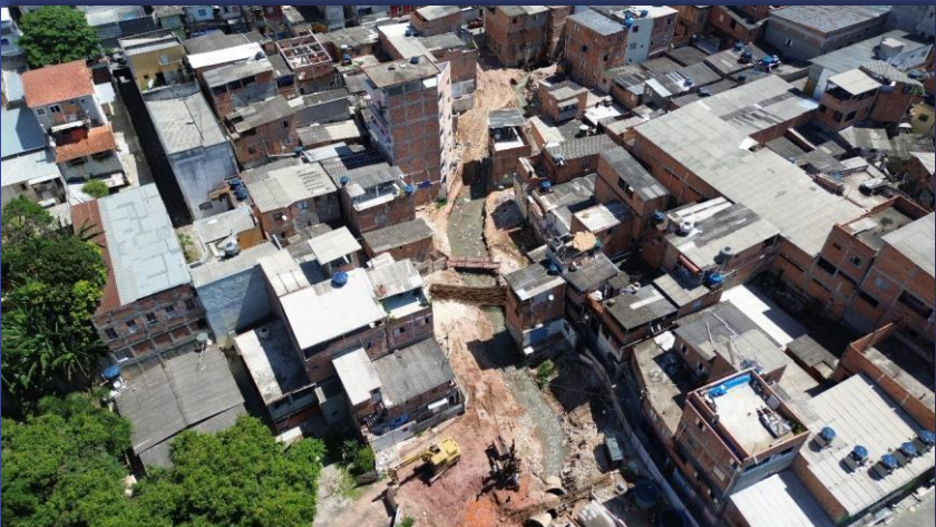
Vista aérea da obra
