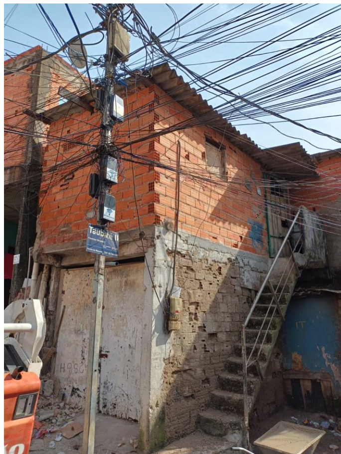
Melhoria externa da edificação - ANTES
