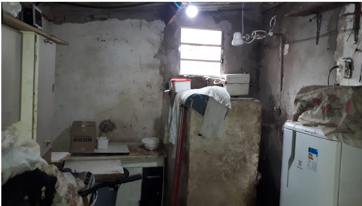
Melhorias internas da edificação - ANTES
