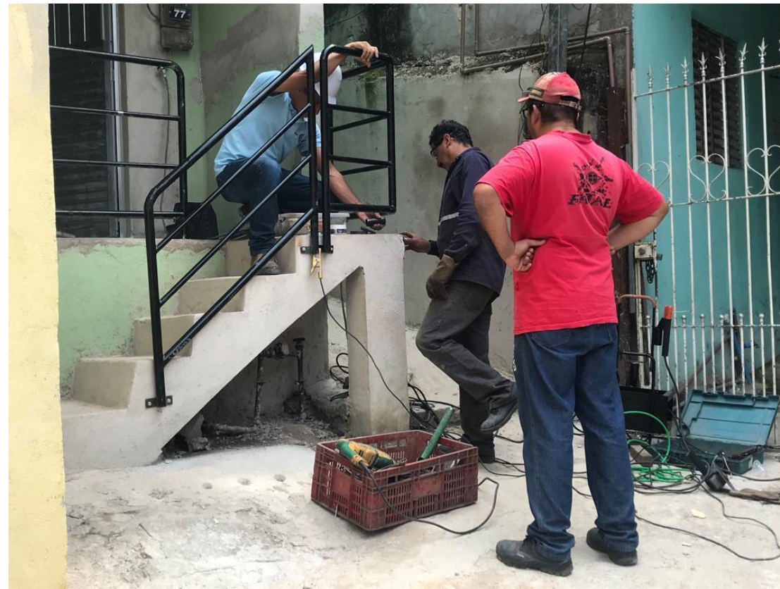
Instalação de guarda-corpo – DURANTE
