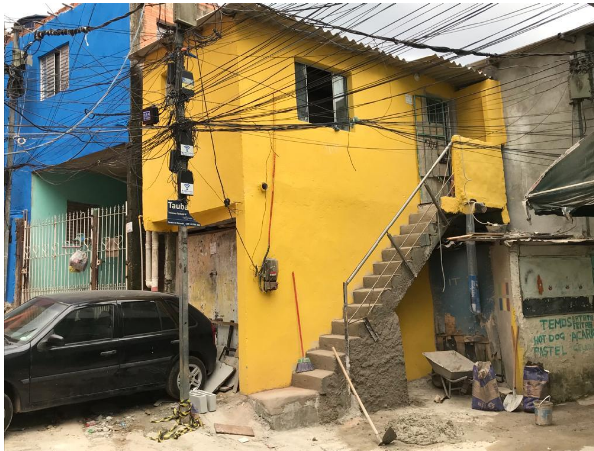
Melhoria externa da edificação – ATUAL (obra em fase de finalização)
