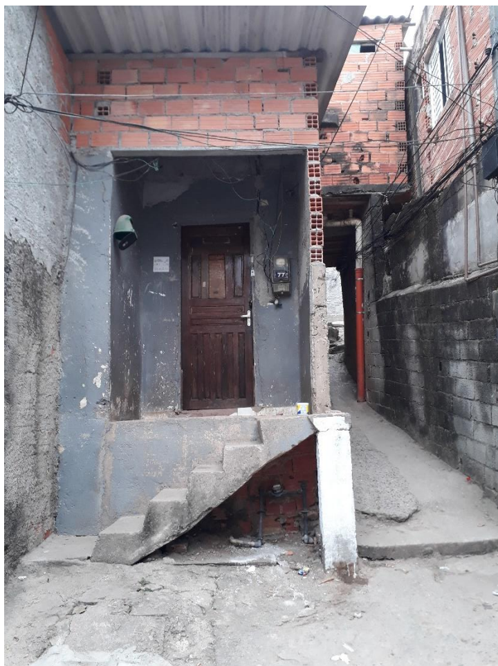
Melhoria externa da edificação - ANTES
