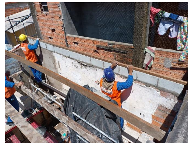
Substituição do telhado da edificação - DURANTE
