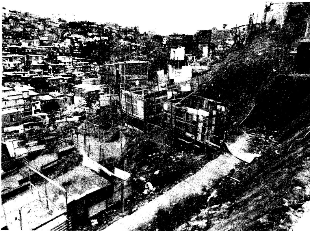
Foto 6: Um escorregamento num ponto qualquer do talude pode provocar um efeito dominó, caindo umas sobre as outras.
