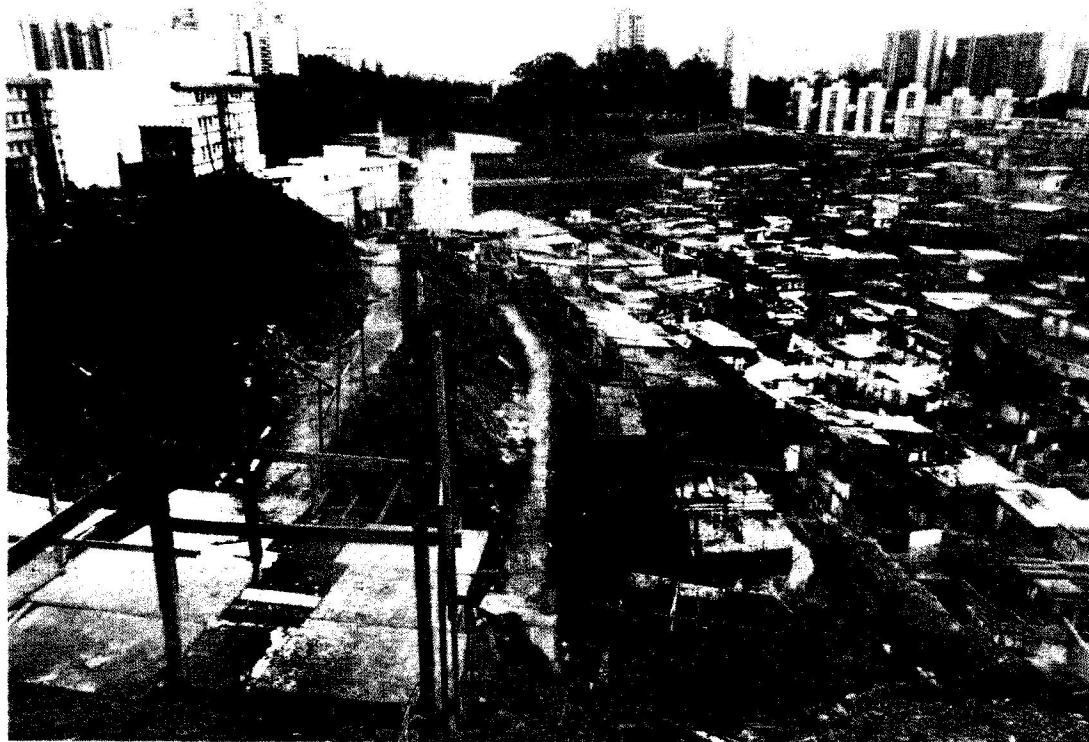
Foto 1: Vista geral das ocupações no talude em obras.
